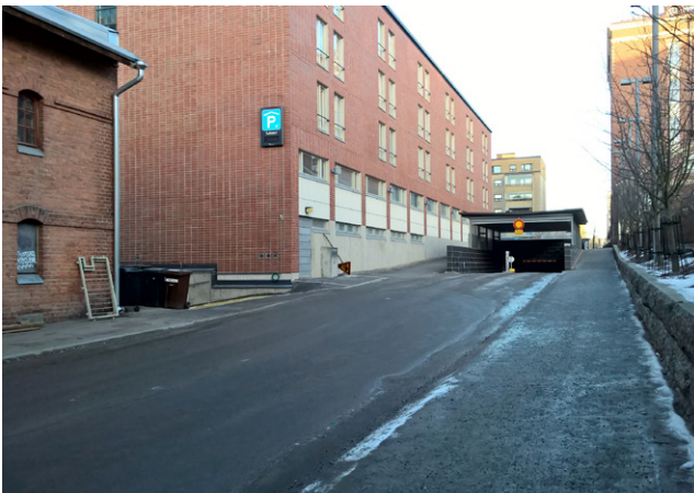
Attilan kiinteistön nykyinen ajoramppi Pinninkadulla puretaan.
